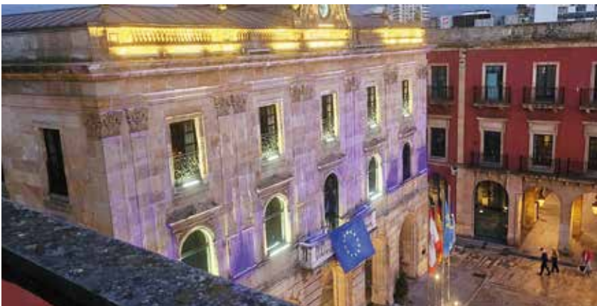
El Ayuntamiento de Gijón siguió fiel a la tradición de iluminar de morado su fachada.
